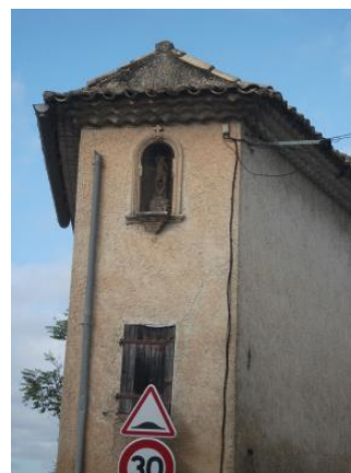
Statue extérieure sur l'ancienne chapelle de Saint Sébastien (19 e siècle), Venue de Carpentras / Ch d'Aubignan, CC 248
