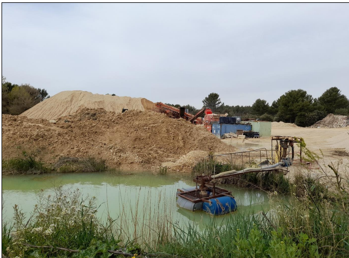
Figure 9. Vue sur l'exutoire du bassin de décantation et la pompe de prélèvement immergée
