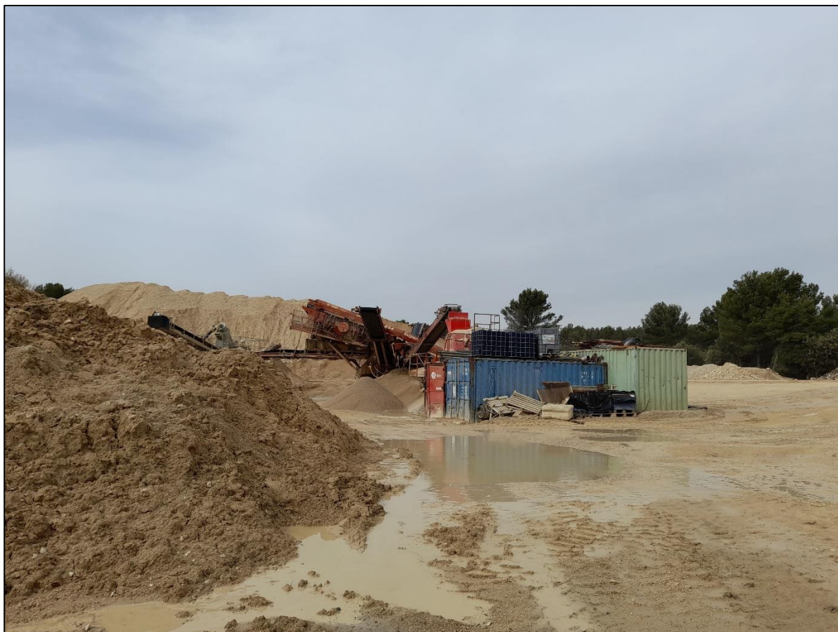
Figure 7. Vue sur les 3 containers de stockage et l'installation de traitement
