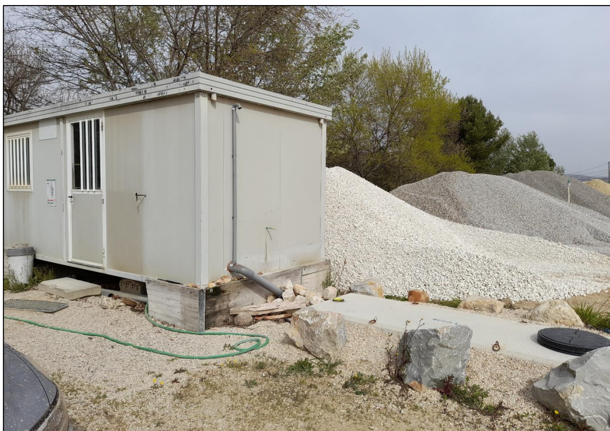
Figure 8. Vue sur le bungalow social et la fosse toutes eaux (enterrée)
